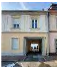
pogled na dovoz iz ulice na dvorišče
