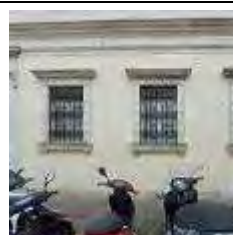
desna stranska fasada, okna
