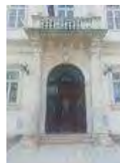
vhod s portalom, balkon
