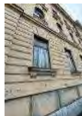
detajl desne fasade
