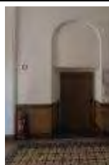
hodnik, vrata v servisne prostore, detajl stene
