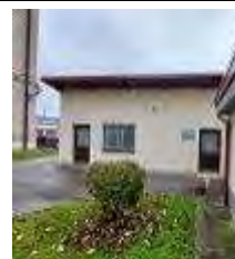
dvoriščna fasada, vložišče
