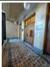
glavno stopnišče, ploščice na podestih
