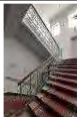
stopnice in okna na stopnišču
