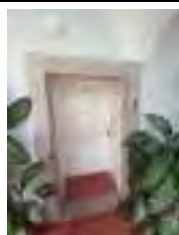
vrata, detajl stropa
