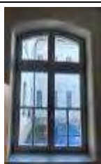
okno, obnovljeno od znotraj
