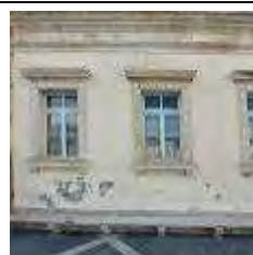
glavna fasada, detajl
