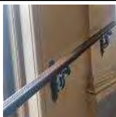
glavno stopnišče, kovinska detalja lesene ograje
