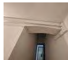
detajl stropa na hodniku v klet
