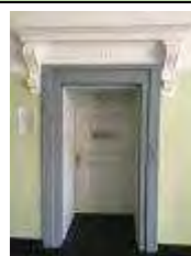
vrata, štukature, portal, 2. nadstropje
