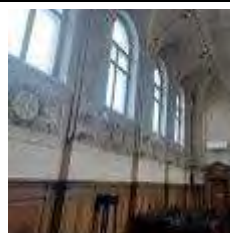
razpravna dvorana 30, desno
