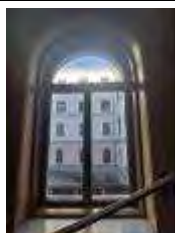
glavno stopnišče, polkrožno zaključeno okno
