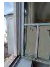
okno, obnovljeno od znotraj
