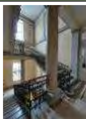
stopnišče, ograja, ploščice, detajl stene
